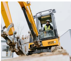
Engins et nacelles : bien manœuvrer, c'est se protéger
